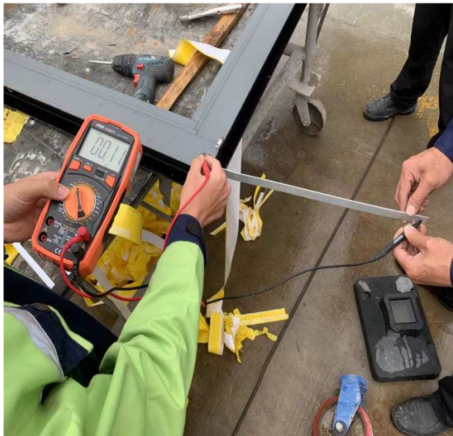
水线过气检查 OK
