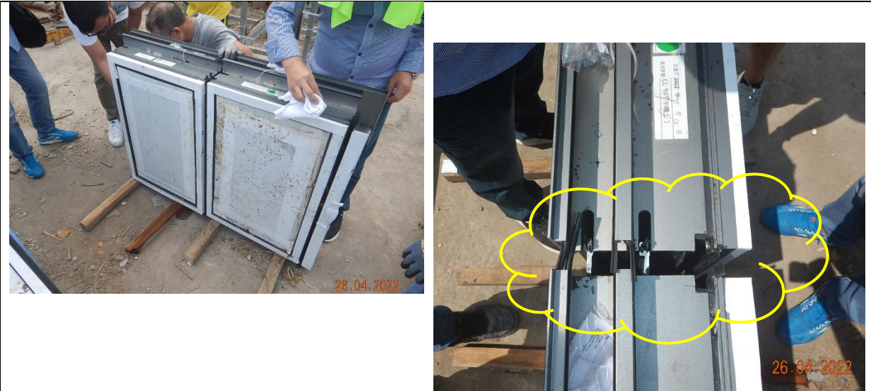
單元板拼合，以測試膠條鬆緊度，PMU 安裝時再視察。
