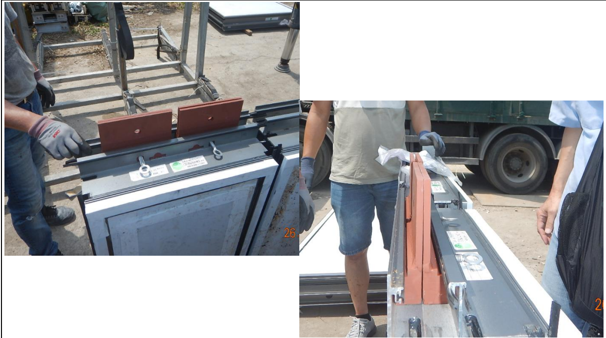
單元板吊具試裝，吊具能夠套入水槽內，並修上螺絲。
