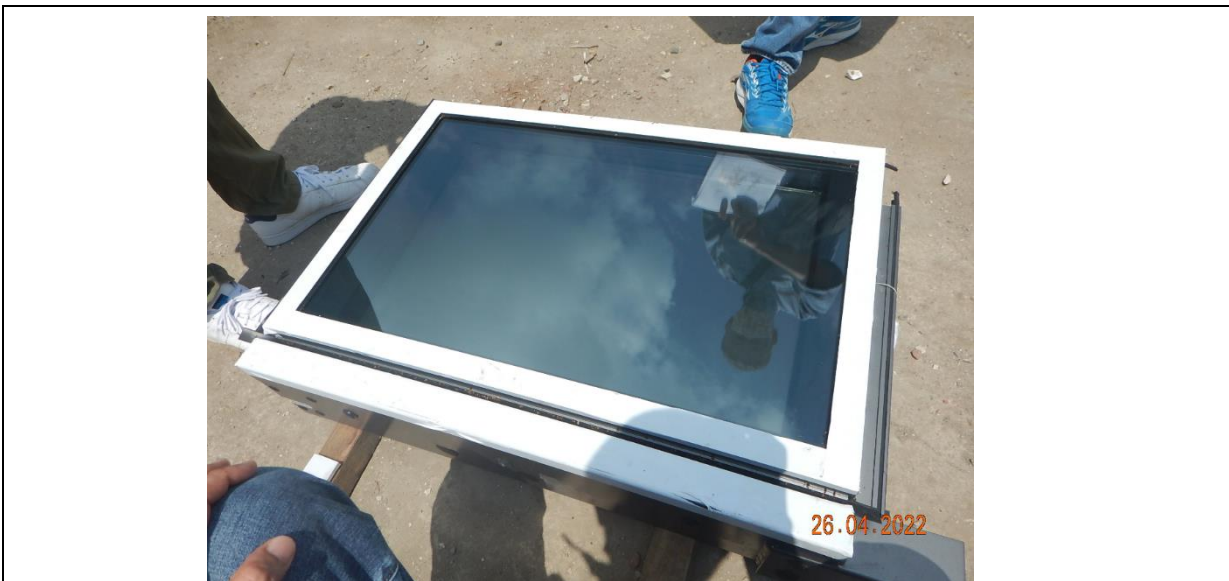
拆除單元板保護膠紙檢查，玻璃沒有花痕。
