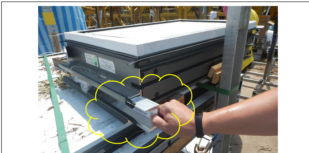
單元板水槽套芯試裝，套芯能夠套入水槽內，尺寸合適。
