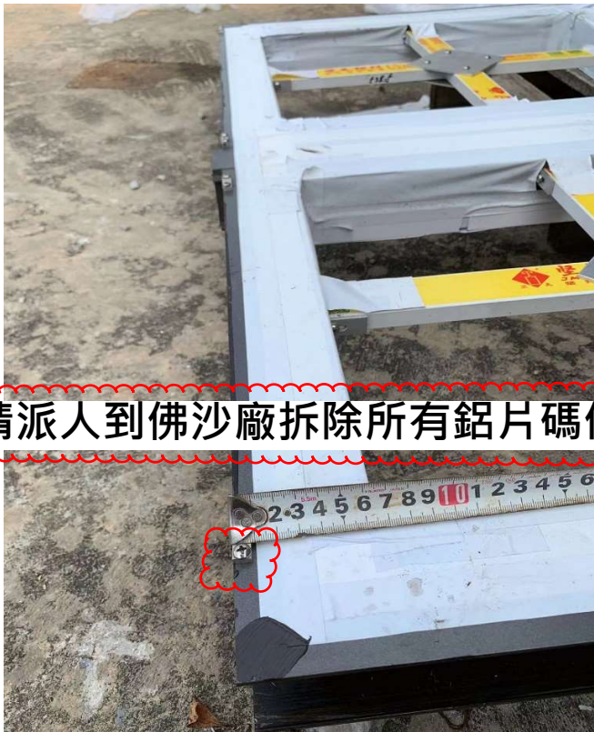
外墙顶部铝片码仔入泥 10mm 会影响到铝窗无法放入，完全贴合窗托
