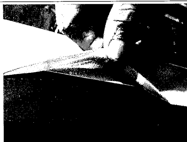
膠紙保護 1. 膠紙至少包 2 層，而且在轉角位需增加膠紙斜包。底帖膠紙包裝位置需到批盪邊；底帖膠紙包裝位置需到石矢邊。
