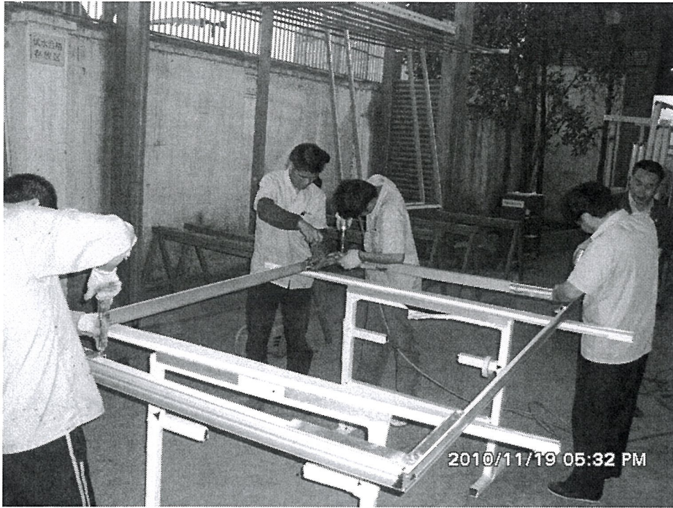
拆卸鋁窗夾口加固槽—以備再次進行試水測試
