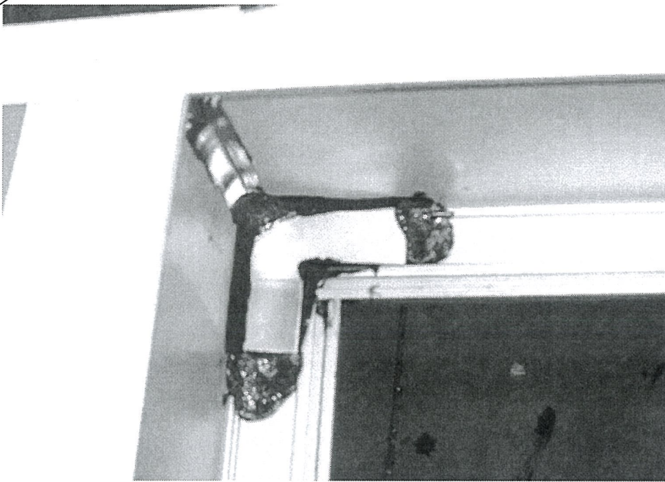
夾口位置加防水鋁片--以提高防漏水效果
