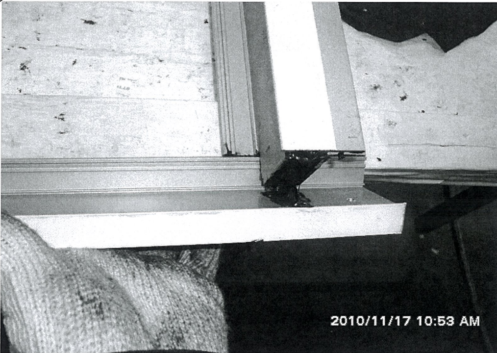
組框前先在橫料接口位置注防水膠--以提高防漏水效果
