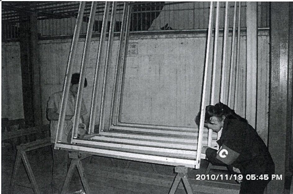
進行鋁窗防漏水的二次測試—檢測經過多次搬運後防漏水的效果
